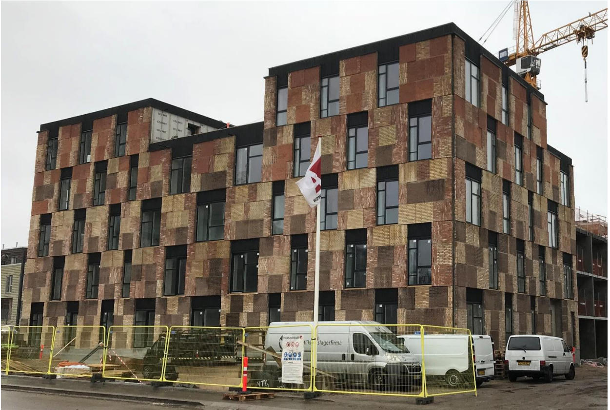
Kuva 8. Kööpenhaminassa sijaitseva asuntorakentamishanke "Ressourcerækkerne", jonka esivalmistetut julkisivupaneelit on koostettu eri lähteistä peräisin olevista erivärisistä tiilistä.
